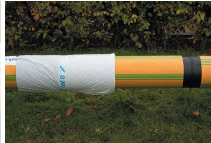
Krimpmantel wordt over las geschoven
