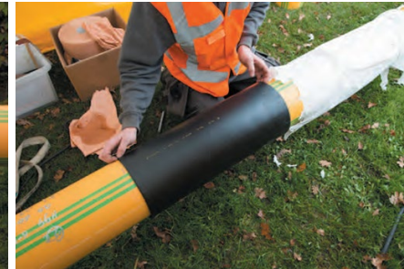
Verpakking krimpmantel wordt verwijderd
