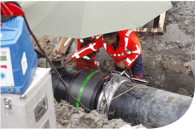
Aanbrengen PE-HD elektrolasmof dia. 800 mm
