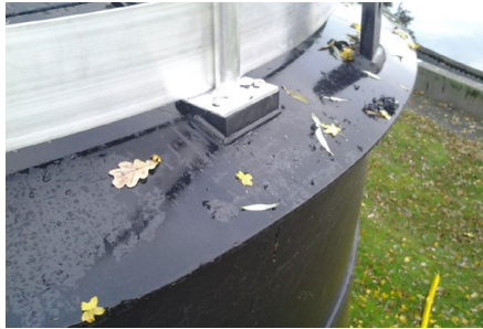
PE-HD voorziening t.b.v. RVS steunen op tanks
