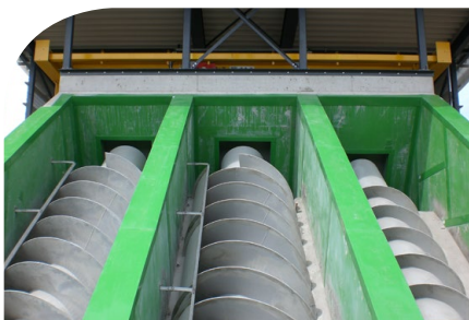
BKU II PE-HD T-grip aangebracht in vizelgoot
