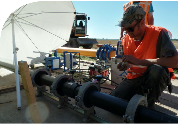
Aanbrengen PE-HD elektrolasmof dia. 125 mm vlg NTA 8828
