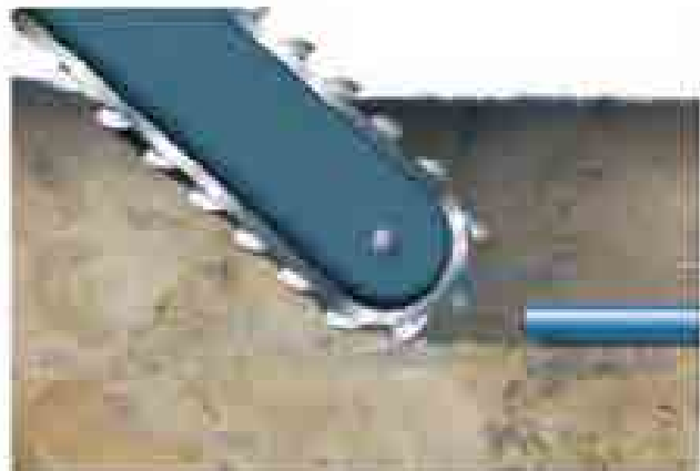
Afb. 2-5: Bij de freesmethode wordt de afgegraven bodem als opvulmateriaal gebruikt; daarom wordt het gebruik van buissystemen met geïntegreerde beschermlagen aanbevolen.
