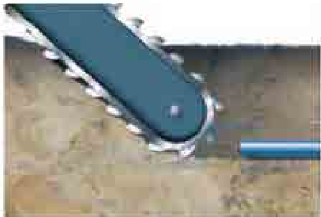
Afb. 2-5: Bij de freemethode wordt de afgegraven bodem als opvulmateriaal gebruikt; daarom wordt het gebruik van buissystemen met geïntegreerde beschermlagen aanbevolen.
