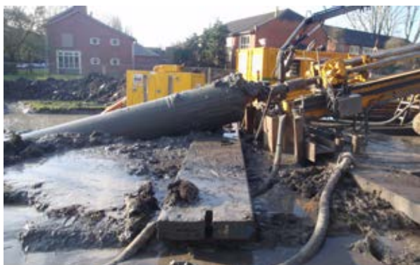
HDD, horizontaal gestuurd boren
